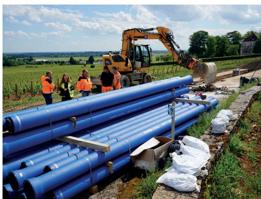
Travaux sur le réseau d'eau potable à Aloxe-Corton
