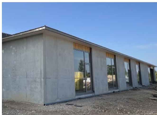
Centre sportif LADOIX
