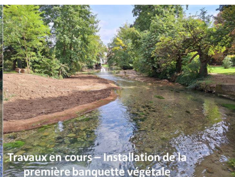
Travaux en cours – Installation de la première banquette végétale
