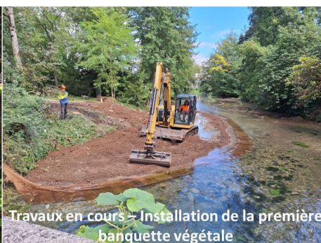
Travaux en cours – Installation de la première banquette végétale
