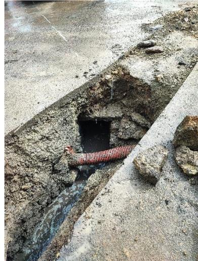
**BLIGNY LES BEAUNE:** Curage et inspection caméra sur 645 ml qui démontre des problèmes d'effondrement et de colmatage sur 370 ml.
