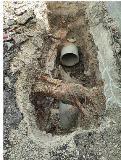
**BEAUNE** : Rte de Pommard et Rte de Verdun remise en état des réseaux des eaux pluviales dégradés à cause des arbres.
