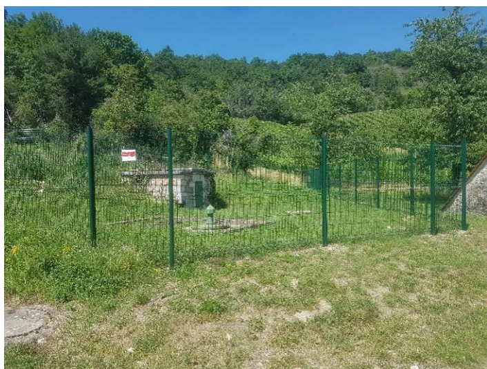
Périmètre immédiat clôturé AUXEY Bourg
