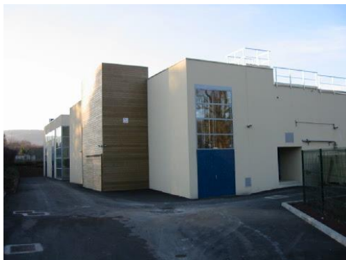
Station de potabilisation de la Bouzaise
