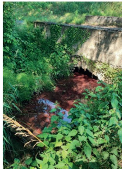
*Hydrocarbures sortant du réseau des eaux pluviales avant intervention.*
