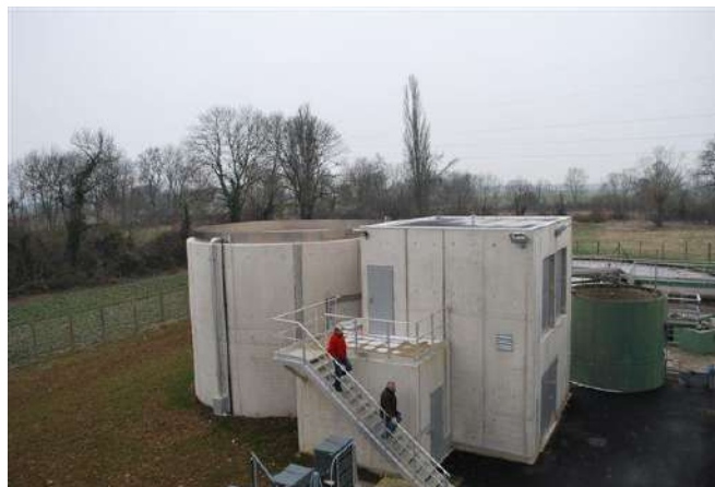
Réacteur à flore fixée fluidisée (R3F) utilisé uniquement pendant les vendanges
