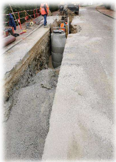
Travaux quartier Lavirotte Nolay
