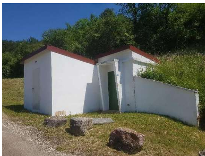
AUXÉY Melin réservoir et traitement charbon
