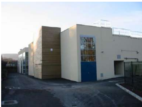
Station de potabilisation de la Bouzaise
