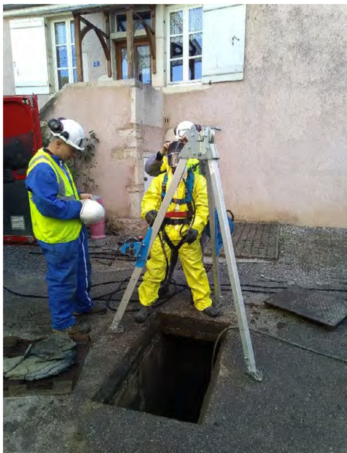
Descente d'un intervenant dans le dessableur
