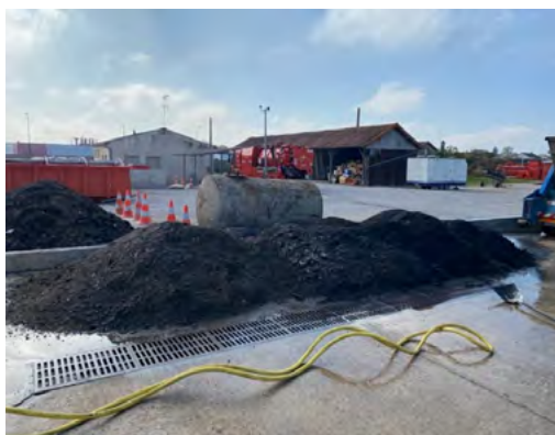
Dessableur en cours de charge
