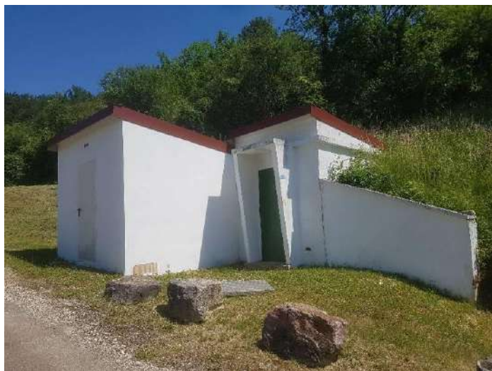
AUXEY Melin réservoir et traitement charbon
