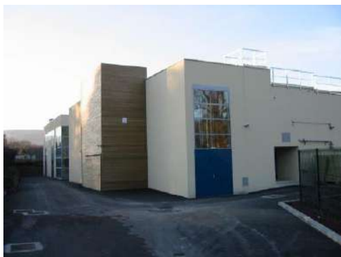
Station de potabilisation de la Bouzaise
