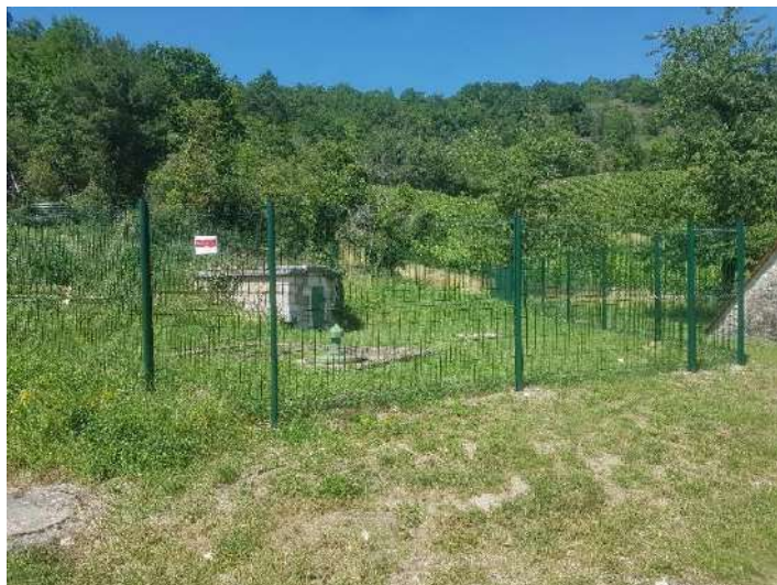
Périmètre immédiat clôturé AUXEY Bourg
