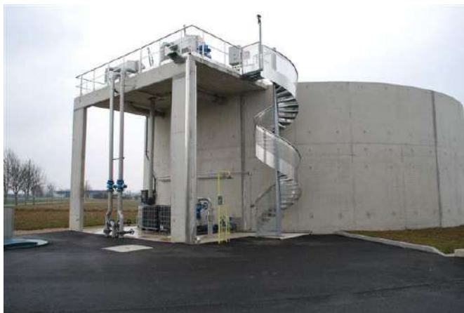
Bassin de stockage des effluents vinicoles de la STEP
