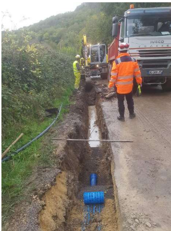
Renouvellement du réseau sortie réservoir Vauchignon (amélioration du débit /pression)
