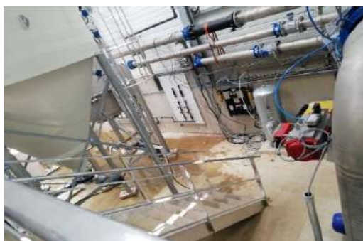
Station traitement des pesticides et décarbonatation BS1
