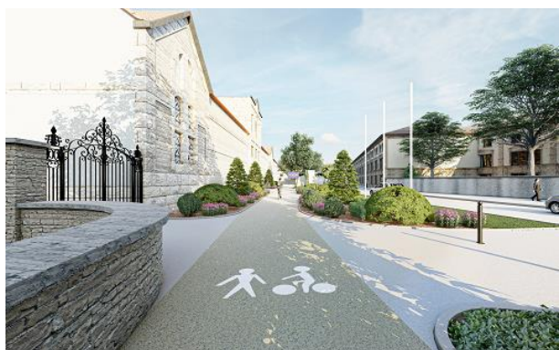
Premières tranches de travaux autour du boulevard circulaire
