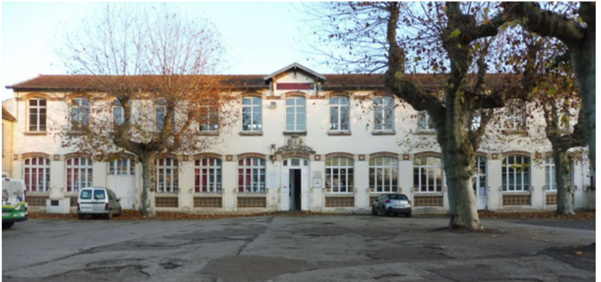
Espace Claude Foret – bâtiment principal
