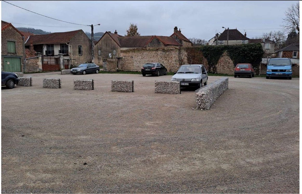
Quartier Saint Pierre : plateforme de stationnement
