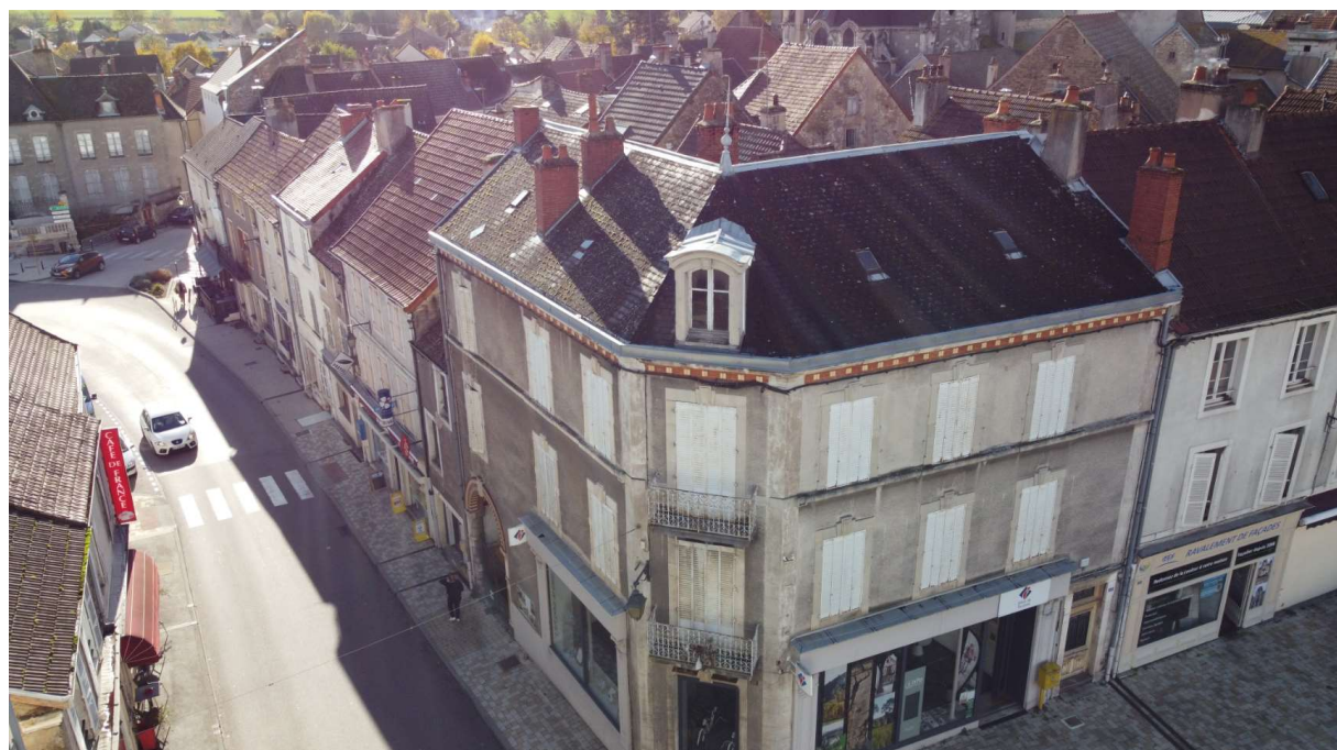
Vue sur façade rue de la République
