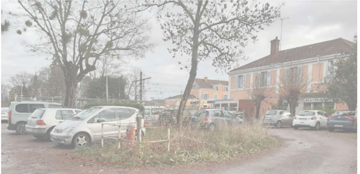
Vue avant travaux
