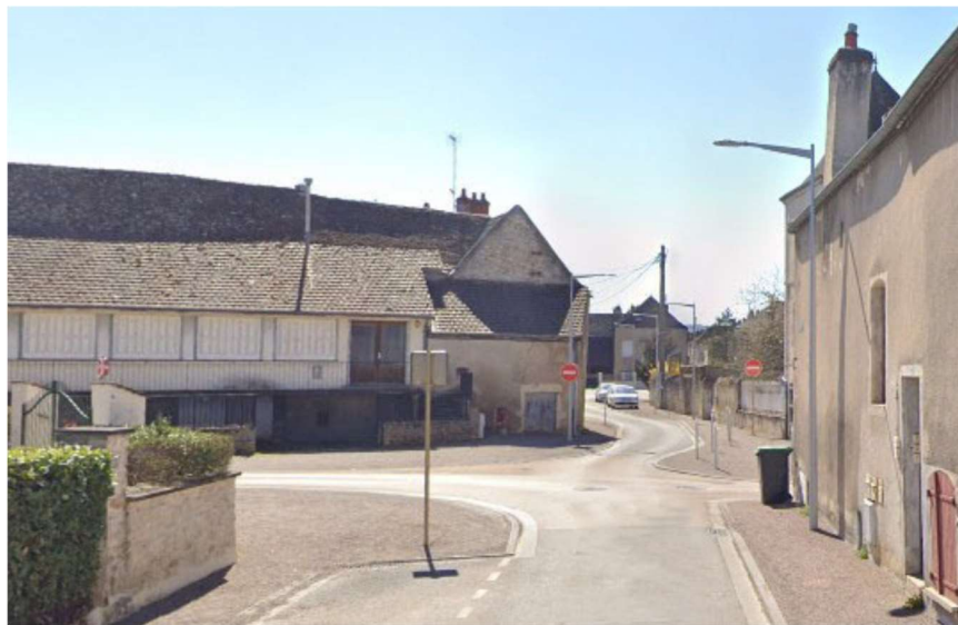
Vue sur façade rue de Chaudenay
