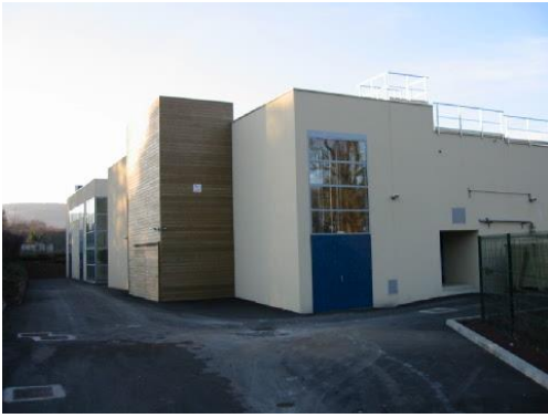
Station de potabilisation de la Bouzaise
