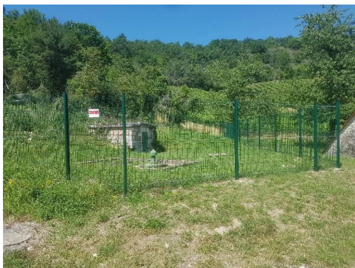
Périmètre immédiat clôturé AUXEY Bourg
