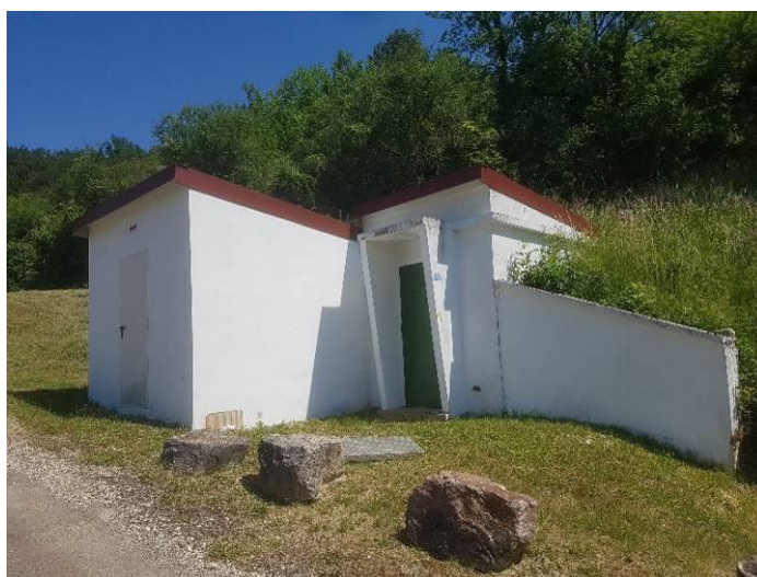
AUXEY Melin réservoir et traitement charbon
