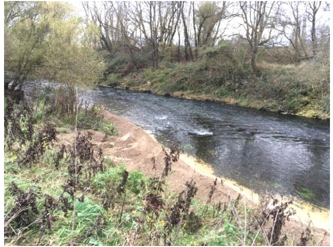
Après travaux (23 novembre 2021)
