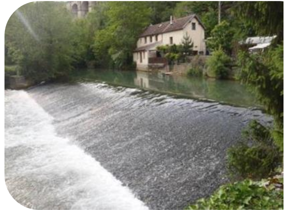
Déversoir de la Verrerie, 2013.
