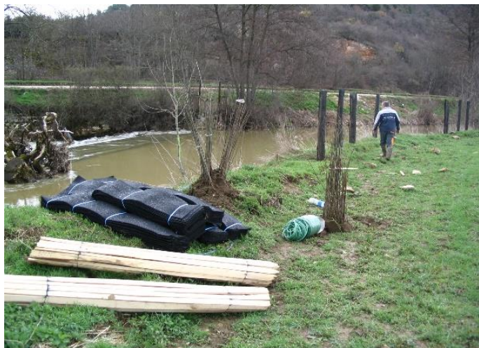
Chantier des plantations à Veuvey-sur-Ouche - 2006
