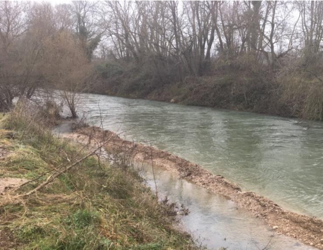
7 décembre 2021 : Crue annuelle
