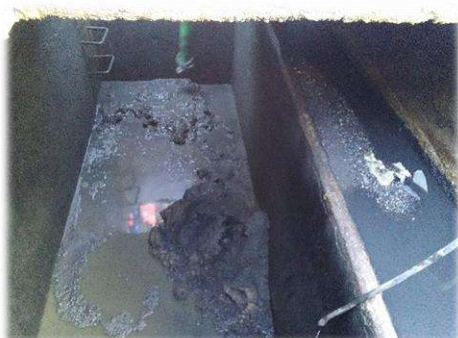
Dessableur en cours de curage
