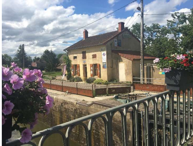
Figure 8: Maison éclésièrre à Rully
