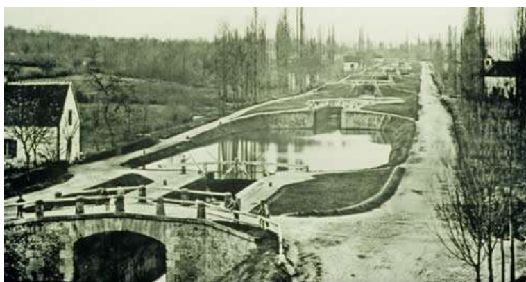
Figure 9 : Les sept écluses à Ecuisses vers 1880
