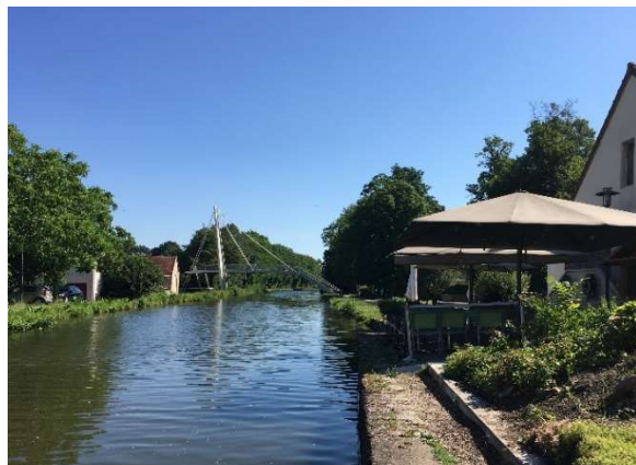
Figure 16 Passerelle à Saint-Léger-sur-Dheune
