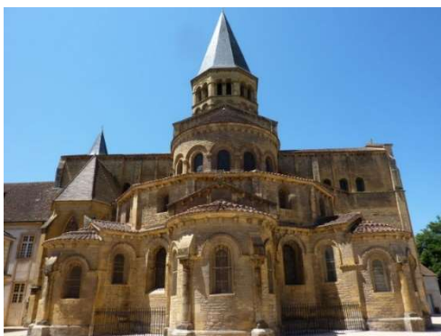
Figure 15: Aperçu de la partie arrière de la Basilique à Paray-le-Monial
