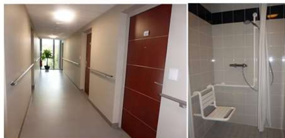
Aménagement intérieur du bâtiment, adaptation de salle de bains.
